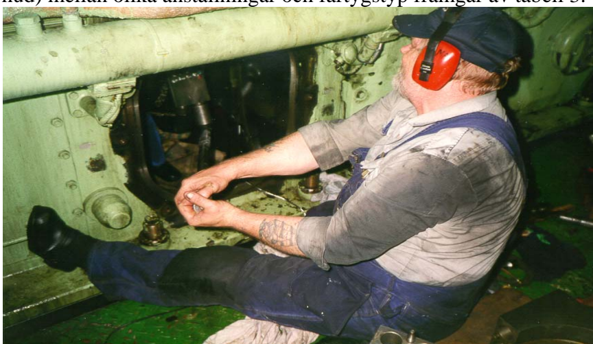
Figur 3. Arbeta med kolvhalning på huvudmaskin.
